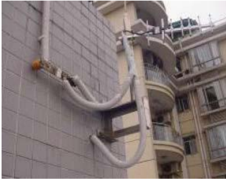
線穿牆走 U 字形，不要太彎曲電纜，以免折壞。
